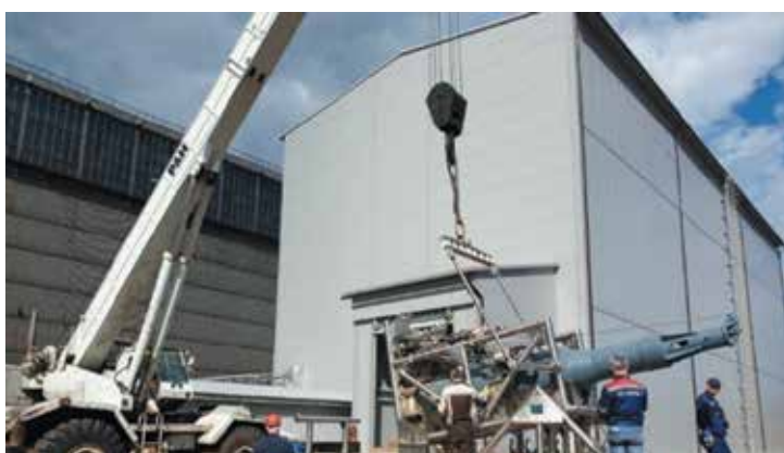
Рис. 5.54 – Защитное укрытие для безопасного извлечения ОЯТ из носовой блок-упаковки
