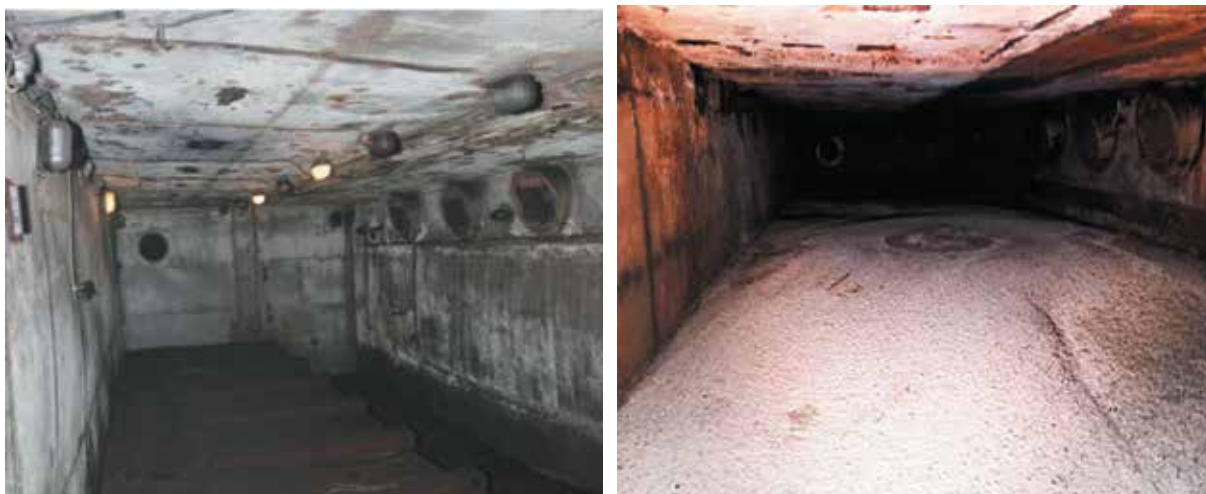
Рис. 5.11 – Помещение до и после демонтажа облицовки стен, пола и потолка и частичного заполнения его бетоном
