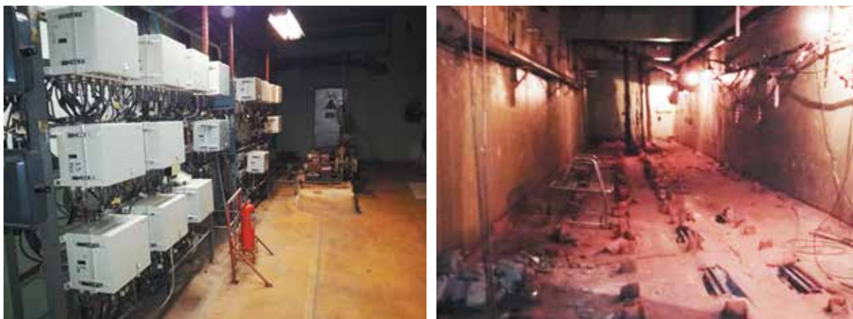
Рис. 5.10 – Помещение до и после демонтажа оборудования систем радиационного контроля и управления
