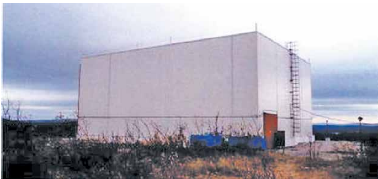
Рис. 5.35 – Сооружение «укрытие», возведенное над хранилищами ТРО
