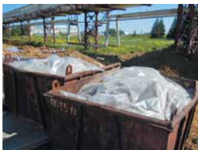
Рис. 5.30 – Вывоз строительных остатков и грунта от ликвидации сооружения № 136
