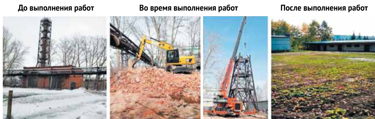
Рис. 5.16 – Вентцентр и выбросная труба здания № 18 до и после выполнения работ
