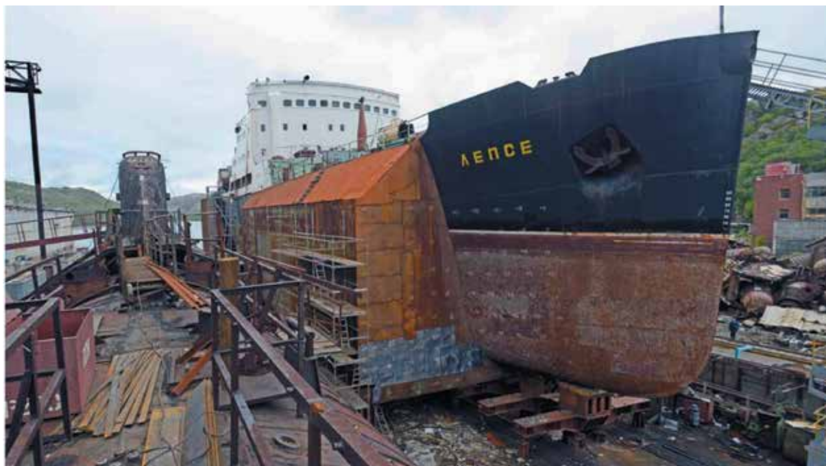
Рис. 5.53 – Плавтехбаза «Лепсе» на стапельной плите на СРЗ «Нерпа»
