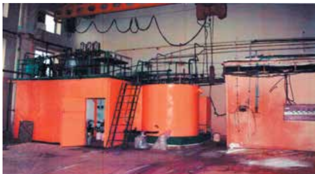
Рис. 5.44 – Помещение № 153 в здании № 500: исходное состояние
