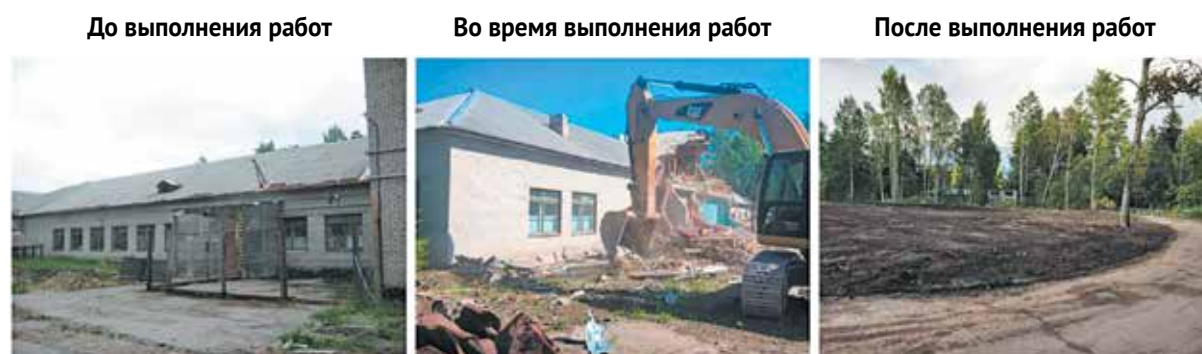
Рис. 5.26 – Корпус № 73 до и после выполнения работ
