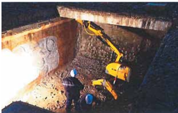
Рис. 5.36 – Дезактивация стен и пола емкостей № 1–4 хранилища ТРО
