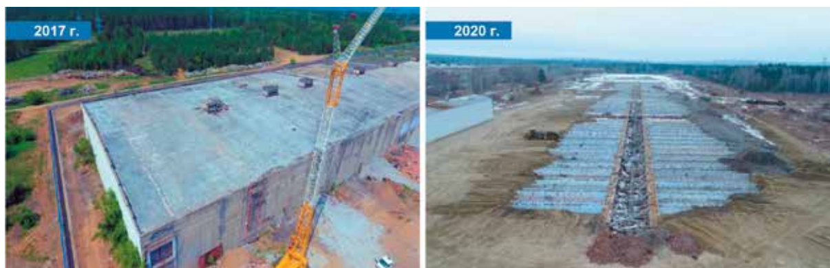
Рис. 5.13 – Здание № 804 до и после выполнения работ
