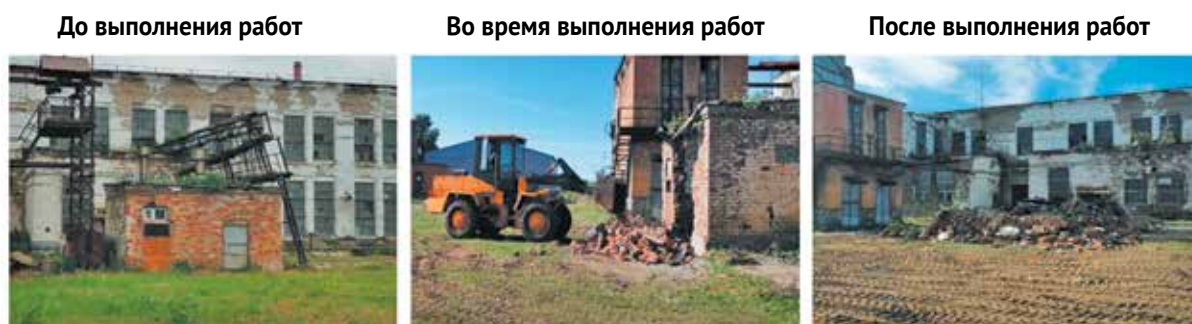
Рис. 5.32 – Здание № 509 до и после выполнения работ
