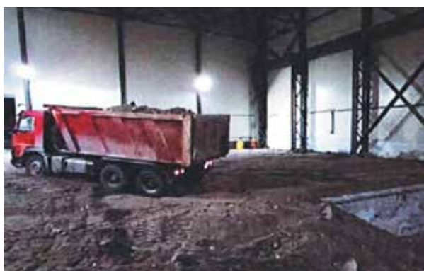
Рис. 5.38 – Проведение обратной засыпки емкостей № 1, 2 хранилища ТРО
