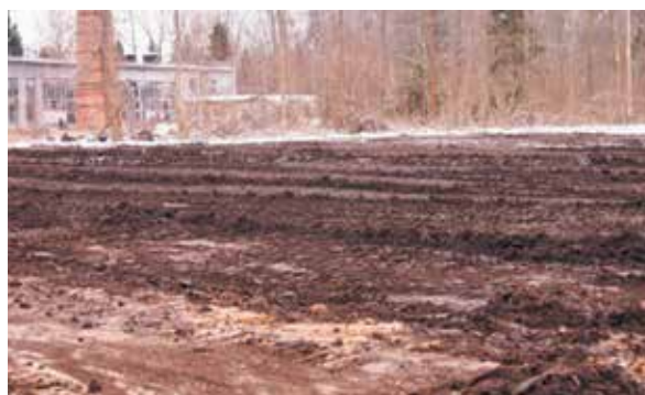
Рис. 6.10 – Планировка территории слоем растительного грунта
