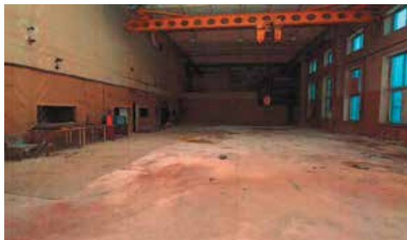
Рис. 5.45 – Помещение № 153 в здании № 500: по окончании работ
