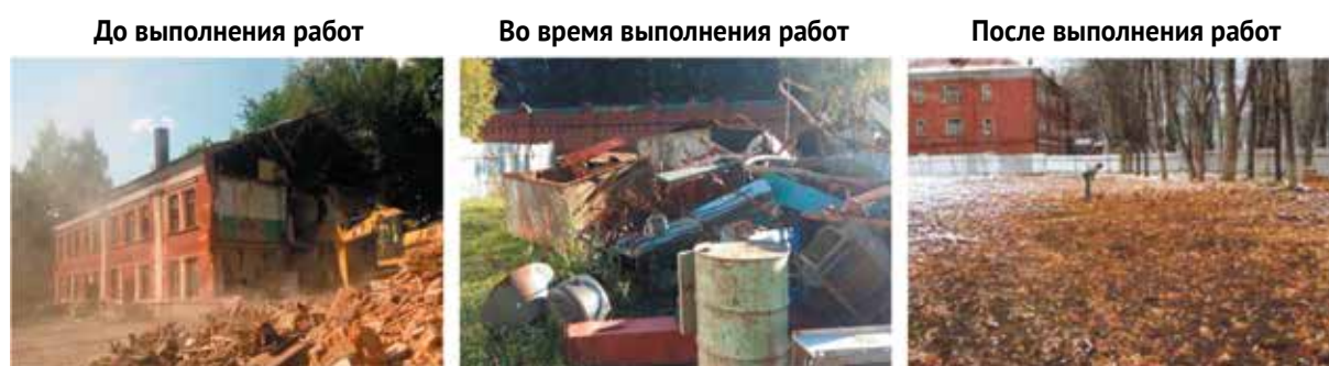
Рис. 5.33 — Корпус № 3 до и после выполнения работ
