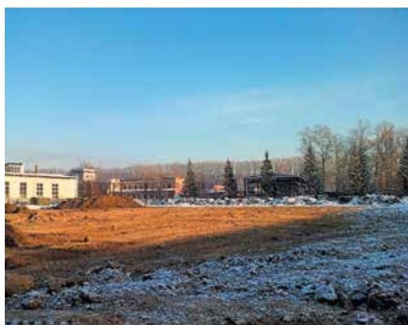
Рис. 5.15 – Внешний вид площадки после завершения работ по обратной засыпке
