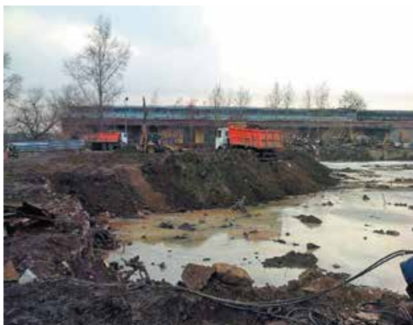
Рис. 5.14 – Рекультивация территории зд. № 73
