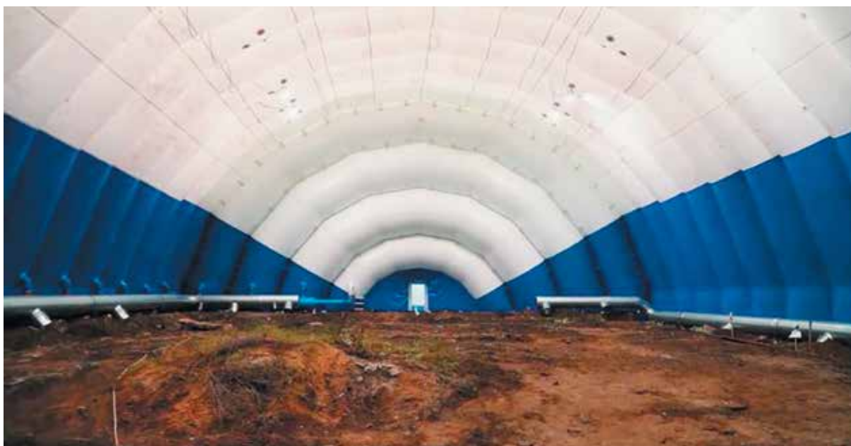
Рис. 5.17 — Возведенная пневмокаркасная защитная конструкция из винила над УРЗ № 9
