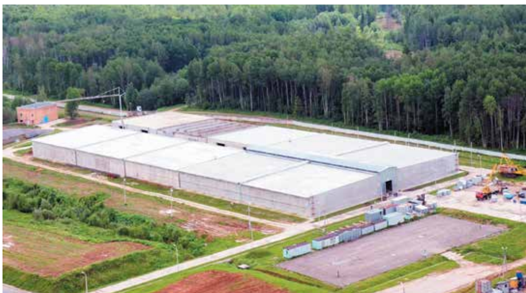
Рис. 4.3 – Общий вид пункта хранения твердых радиоактивных отходов (сооружение № 103) Источник: radon.ru
