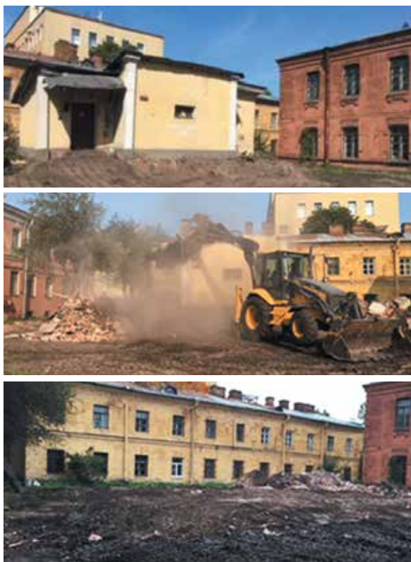
Рис. 6.8 – Здание спецхранилища и прилегающая территория до и после реабилитационных работ
