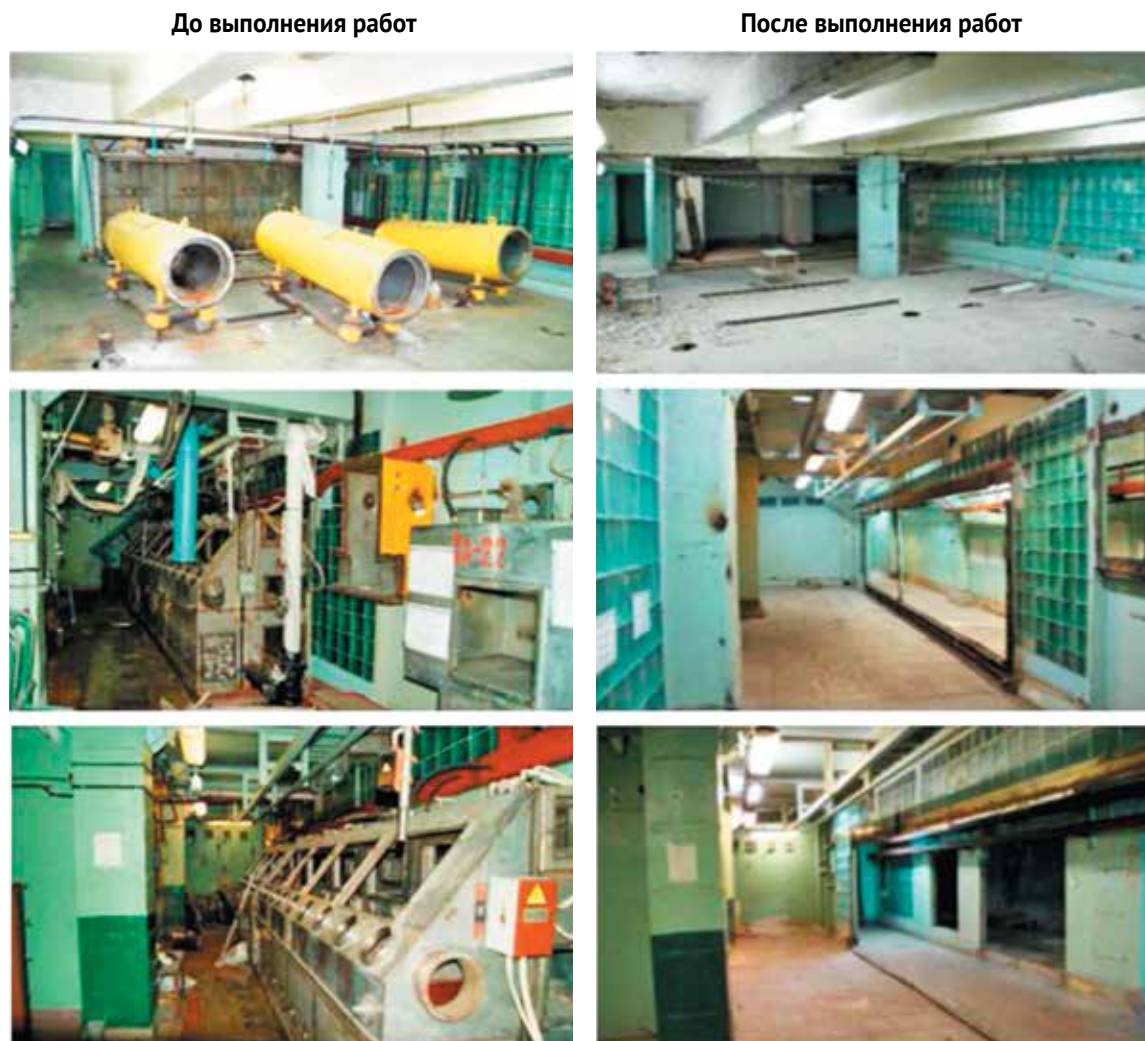
Рис. 5.18 – Помещения установки М2079 до и после выполнения работ
