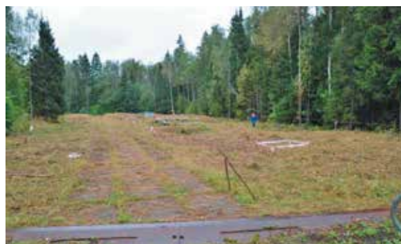
Рис. 6.12 – Территория УРЗ № 10 в процессе проведения работ
