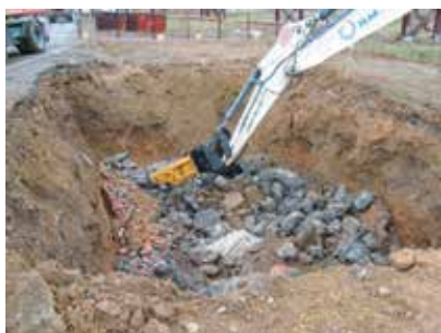
Рис. 5.29 – Демонтаж и фрагментация конструкций сооружения № 136
