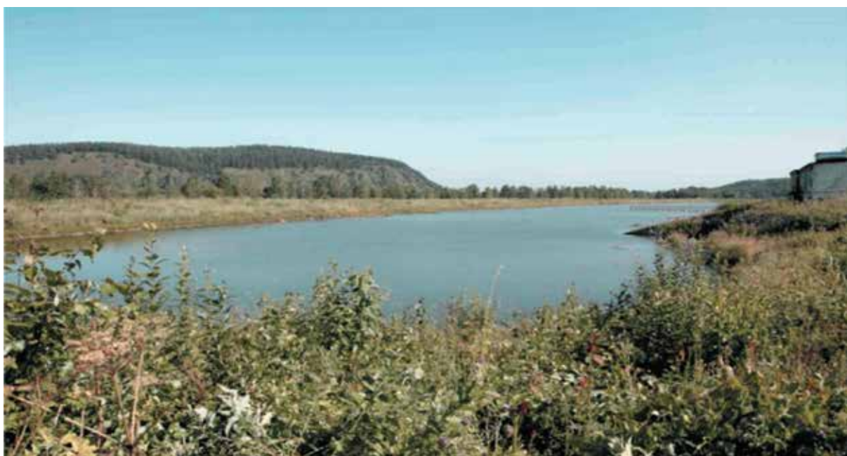
Рис. 5.34 – Общий вид бассейна-хранилища № 365
