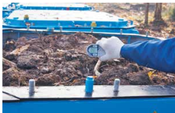
Рис. 6.11 – Сбор, сортировка и упаковка РАО в контейнер
