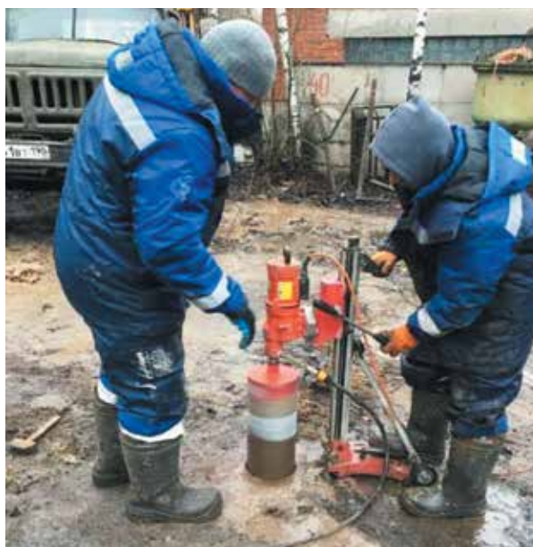
Рис. 5.20 – Работа с установкой алмазного бурения
