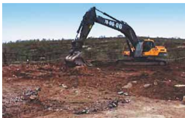
Рис. 5.39 – Обратная засыпка образовавшегося котлована хранилища ЖРО
