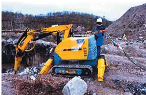
Рис. 5.37 – Демонтаж ж/б стен и днища емкостей хранилища ЖРО
